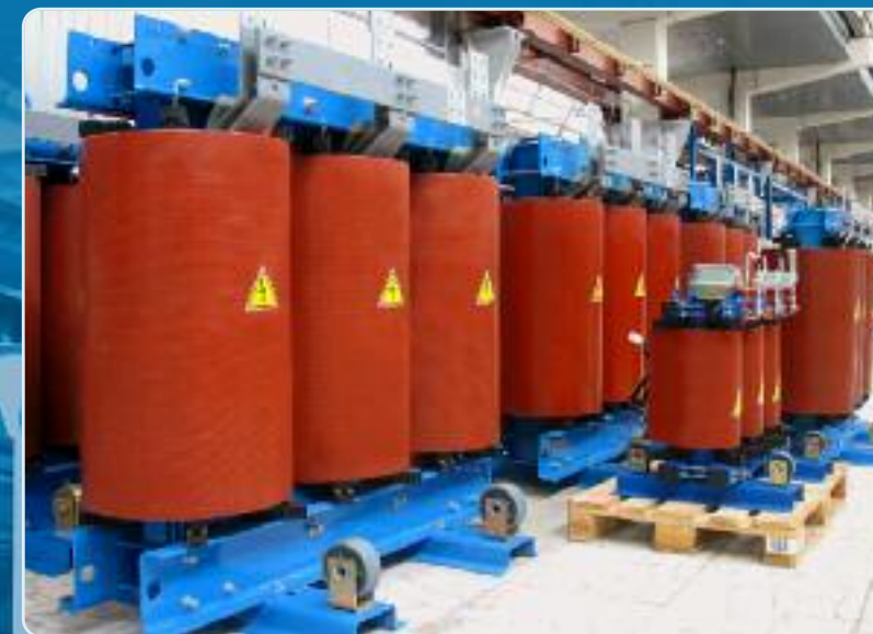
Сухие трансформаторы с литой изоляцией
